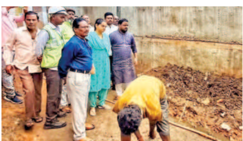
పనులను పరిశీలిస్తున్న గాంధీనగర్ కార్పొరేటర్ పాపన్ వినయకుమార్
